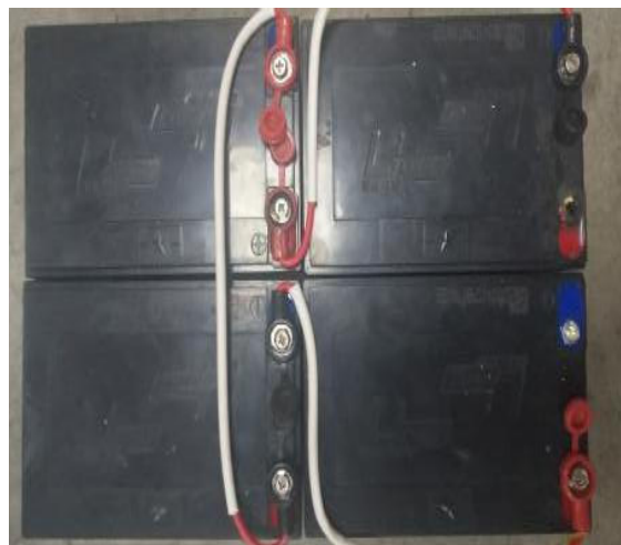
步骤 2：使用电池连接线将电池正确连接在一起
