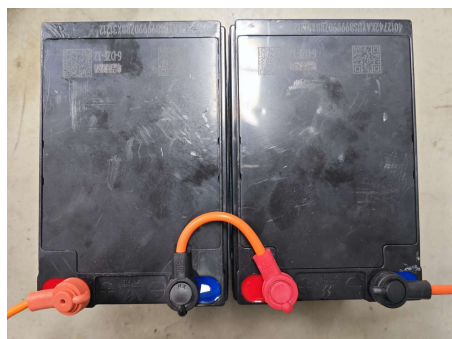
第三步：将电池端子绝缘保护套盖好
